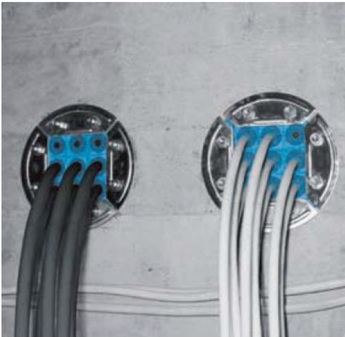
Tesnjenje kablov v cevi
