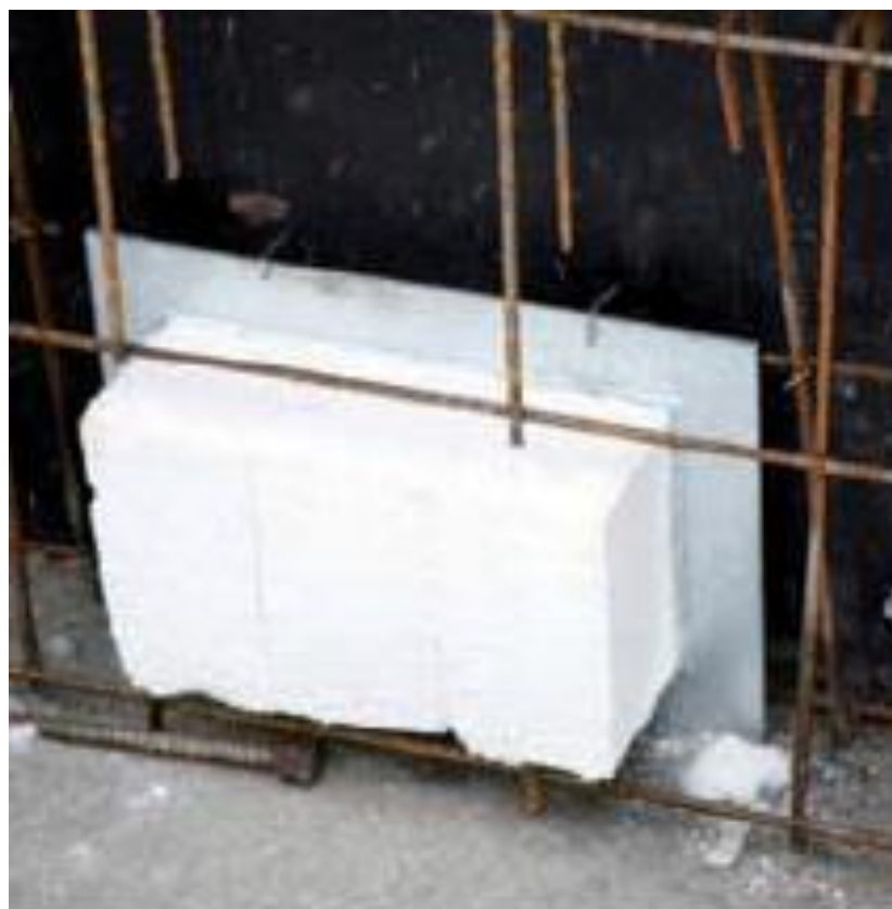
Gradbena priprava okvirja za tesnjenje kablov
